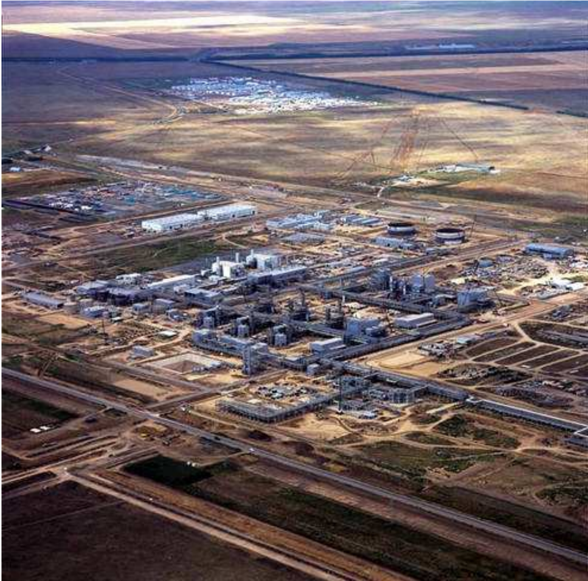
Karachaganak 2000 Panoramica dei nuovi impianti di trattamento gas ed olio con alle spalle il vecchio impianto costruito dai Russi
